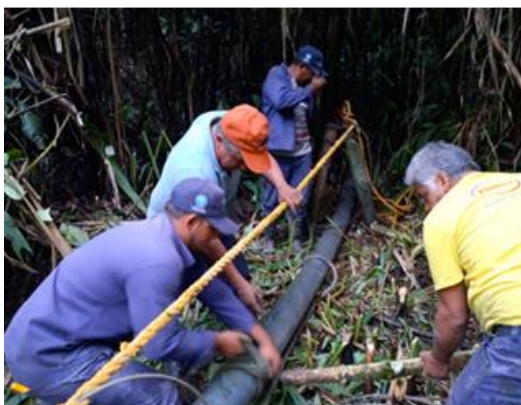
Imagen realizando la reparación red de 6"
