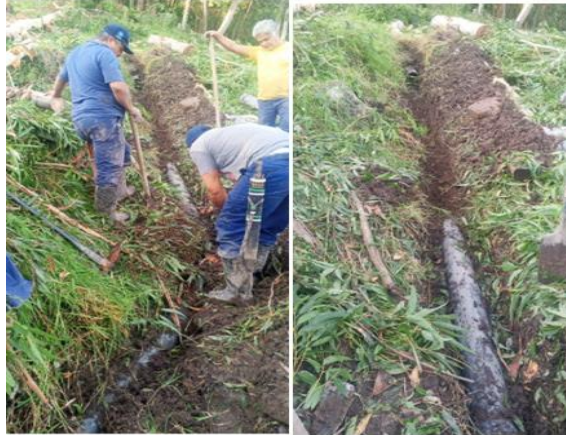
Imagen de la reposición de un tubo de 6"
